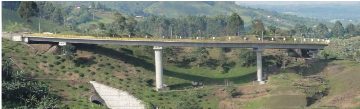
Abb. TB18-6: Fertiggestelltes Viadukt auf der N29 Manizales – Pereira. Foto: Hora.
