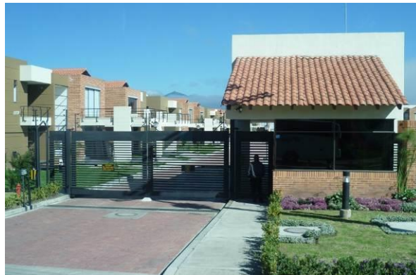
Abb. TB2-7: Eingangsbereich eines barrio cerrado nördlich von Bogotá. Foto: Haushofer, Reichhart.
